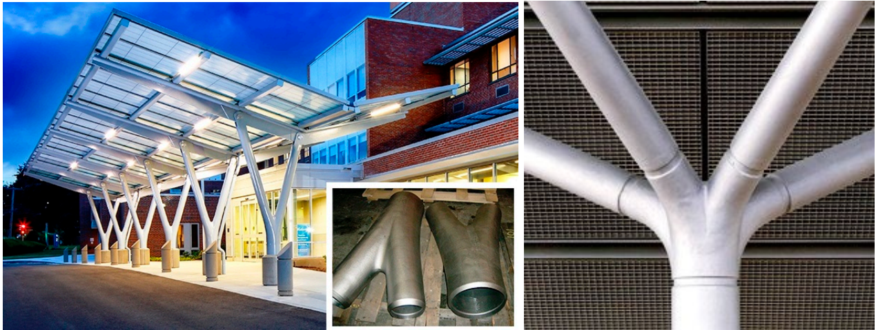
Рис. 5. Застосування сталевих вузлів в опорах навісу перед входом у шпиталь, а також на трубчастій просторовій конструкції на колоні [6]
