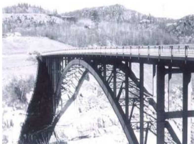
Перший автомобільний алюмінієвий міст у Канаді [287]
