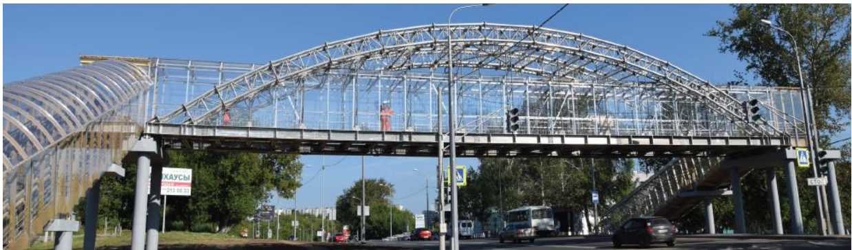
Загальний вигляд алюмінієвого пішохідного мосту в с. Афоніно поблизу Нижнього Новгороду, Росія [286]
