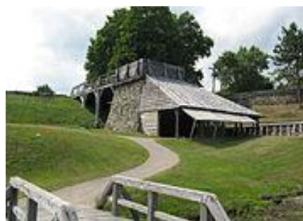
Реконструкція печі в Національному історичному парку Saugus Iron Works, США [22]
